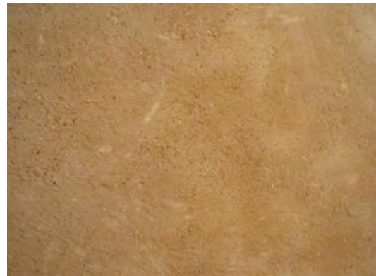
Exemple d'enduit de finition à la chaux
