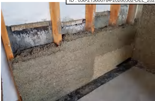
Exemple de mise en œuvre d'isolation par l'intérieur, bâtiment passif
