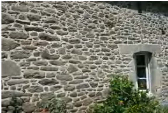
Exemple de joints extérieurs chaux/sable
